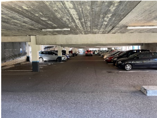
Figuur 23: Uitstraling van de garage is niet erg uitnodigend
