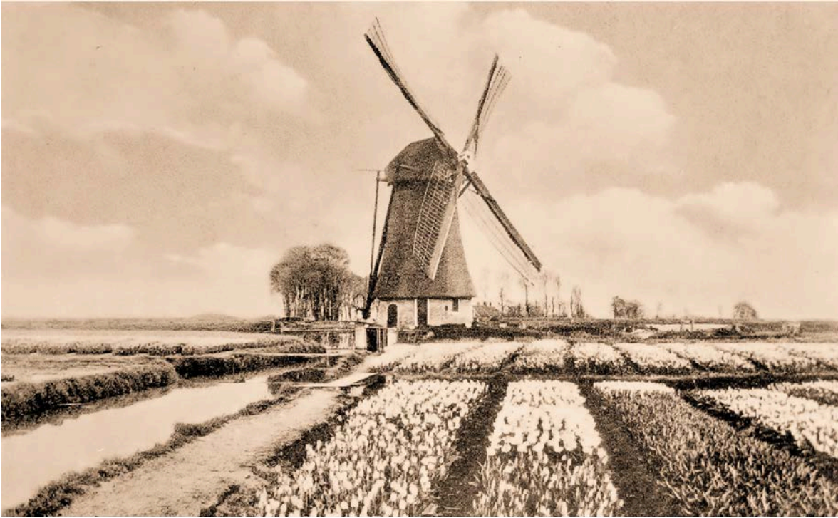
Historisch beeld van molen Venniperpolder. Gebouwd <1615 en deels afgebroken rond 1914. Restanten onderbouw gesloopt in 2012.
