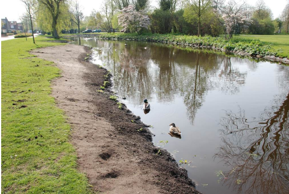
Foto 7. Aanleg natuurlijke oevers (Park Elsbroek)
